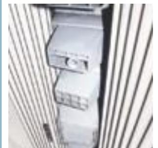
Boquillas de carbón y aire auxiliares
